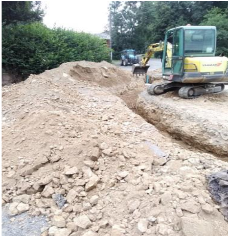
Réfection du réseau d'eau potable au Morel
