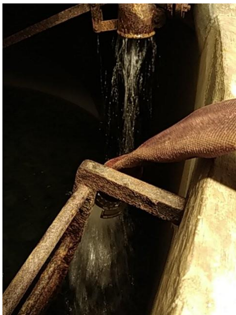
Remplissage du réservoir d'eau par citernes
